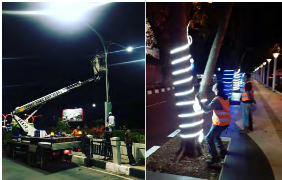
Gambar 4.6 Pemasangan Lampu LED dan Lampu Strep Hias Pohon
